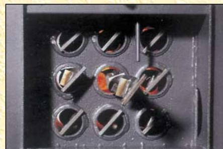
Le faisceau tubulaire vertical avec les turbulateurs de fumées et la sonde de température des fumées.
